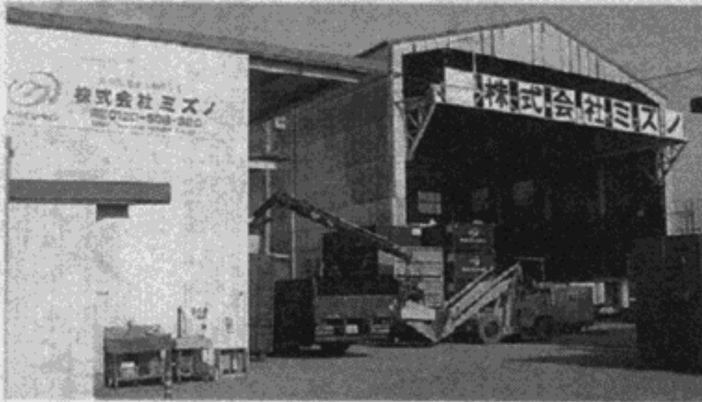
本社隣接地にある中間処理工場
